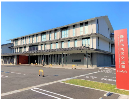
御所市防災交流館
